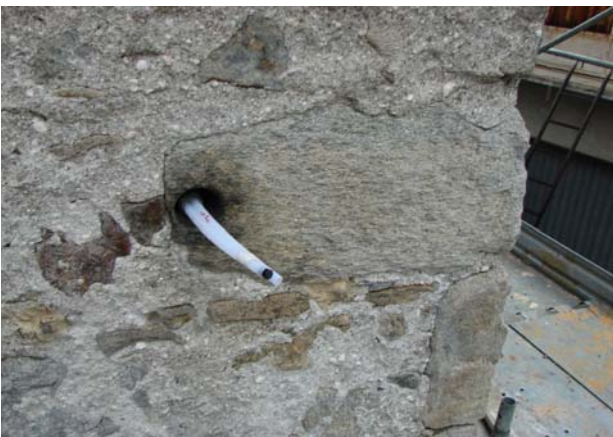
Fasi di perforazione e di iniezione del bulbo di ancoraggio
