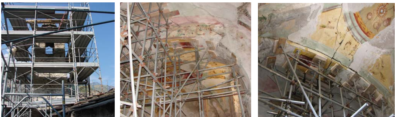
Fasi di montaggio opere provvisionali campanile e arco trionfale
